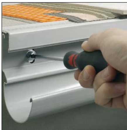
Nachträgliche Montage des Rinnensystems Schlüter®-BARIN an Randprofilen ohne Aufnahmenut
