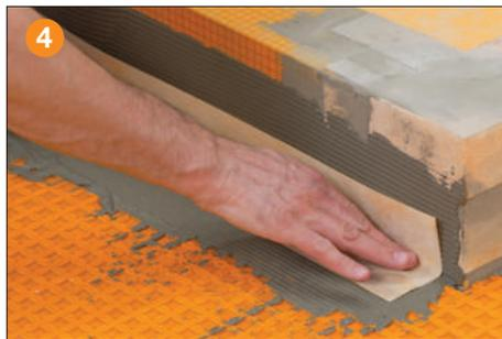
En todas las uniones de paredes, aplique KERDI-BAND como se describe en los pasos 1 a 3, asegurando una superposición mínima de 2" sobre DITRA/-PS/-XL. Instale KERDI-KERECK en todas las esquinas interiores y exteriores.
