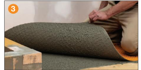
Aplicar un mortero adhesivo adecuado para el sustrato (**mezclado a una consistencia bastante líquida, pero capaz de seguir manteniendo la dentada**).
