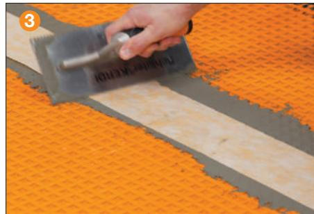
En las uniones, llenar las cavidades con una franja de Schluter SET®, Schluter ALL-SET®, Schluter FAST-SET®, o mortero adhesivo no modificado de aproximadamente 8" (200 mm) de ancho, centrado sobre la unión.
