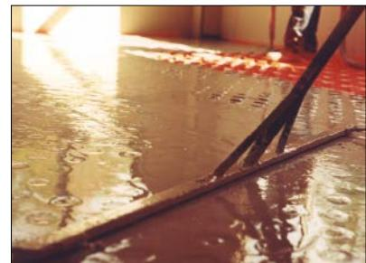
**14.** Alternativ zu **12.** und **13.**: Einbringen eines Fließestrichs: Sorgfältige Verlegung der Noppenplatten und Verschluss der Schnittkanten/Endpunkte. Ein Hinterlaufen der BEKOTEC-Platten ist zu verhindern.
