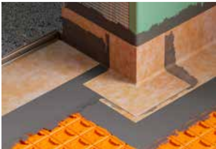
Einbausituation mit Schlüter-KERDI-CID Set 2
