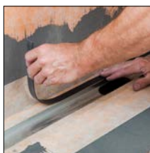
Sobre ponto 1. Em caso de instalação na parede: colar as faixas de cobertura na parede
