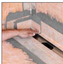
Sobre ponto 3. Colar o ângulo interno KERECK
