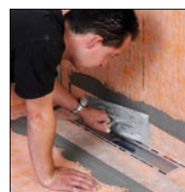
Sobre ponto 4. Colar a guarnição KERDI com KERDI-COLL-L
