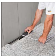
Sobre ponto 4. Medir o revestimento para o suporte de revestimento...
