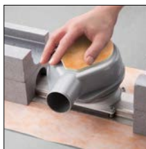
Sobre ponto 3. Colocar a caixa de descarga no adaptador
