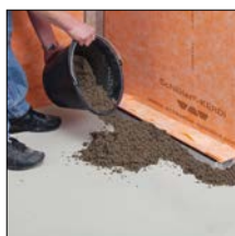
Sobre ponto 5. Aplicar a betonilha
