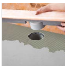
Sobre ponto 4. Colocar o corpo do canal com o suporte do canal
