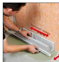
Sobre ponto 1. Alinhar o suporte do canal
