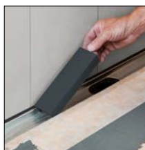
Sobre ponto 2. Inserir distanciadores no corpo do canal
