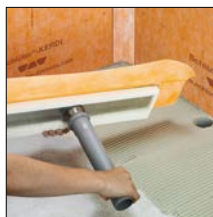
Sobre ponto 2. Instalar o tubo de escoamento
