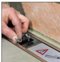
Sobre ponto 2. Com a ajuda do ajuste em altura, colocar a moldura...
