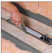
Sobre ponto 3. Suportar a moldura/ colocar o revestimento em toda a superfície
