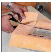
Sobre ponto 1. Cortar a guarnição KERDI
