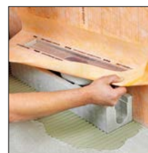
Sobre ponto 2. Instalar o corpo do canal
