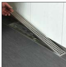
Sobre ponto 4. Colocar a cobertura
