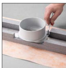
Sobre ponto 3. Aparafusar novamente o adaptador
