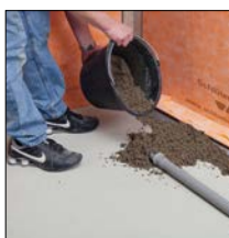
Sobre ponto 6. Aplicar a betonilha inclinada
