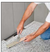
Sobre ponto 5. Aplicar cimento cola no suporte de revestimento
