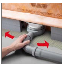
Sobre ponto 5. Alinhar o tubo de escoamento
