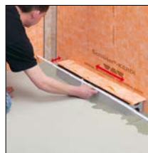
Sobre ponto 4. Alinhar o suporte do canal
