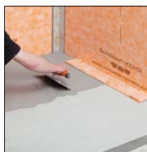
Sobre ponto 7. Aplicar cimento cola
