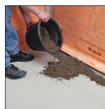
Sobre ponto 3. Aplicar a betonilha de nivelamento
