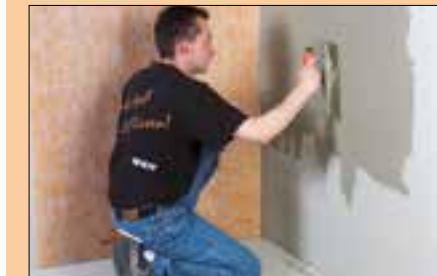
1 Dünnbettmörtel (Zahnung 3 x 3 mm) zur Verklebung der Verbundabdichtung Schlüter-KERDI aufbringen.
