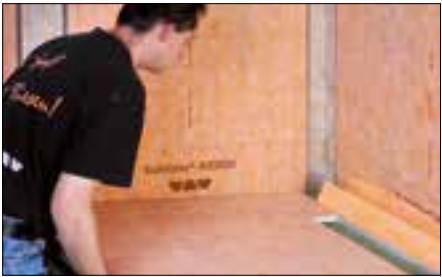
10 Ohne die Rinne anzuheben das Gefälleboard unter den Rand des Rinnenkörpers schieben.
