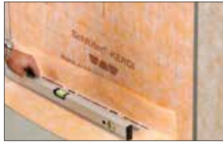
8 Rinnenkörper mit Wasserwaage ausrichten.
