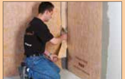
3 Im Stoßbereich mit Schlüter-KERDI-KEBA Band unter Verwendung von Schlüter-KERDI-COLL-L. voll-flächig überkleben.
