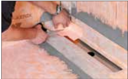
II KERDI Manschette mit KERDI-COLL-L. dicht verkleben. Die im Lieferumfang enthaltene Schlüter-KERECK Innenecke zuschneiden ...
