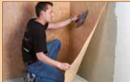
2 KERDI Bahn aufbringen und glätten.
