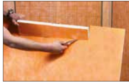
9 Gefälleboard entsprechend der Rinnengröße mit einem Cuttermesser gemäß rückseitiger Schnittmarkierungen ausklinken.
