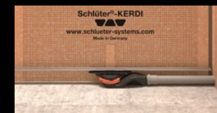
Altura constructiva reducida
