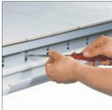
1. Les éléments de gouttières **Schlüter®-BARIN** sont découpés sur mesure et fixés sur le profilé **Schlüter®-BARA** avec les vis fournies. Si nécessaire, une pente peut être établie avec les perforations oblongues.
