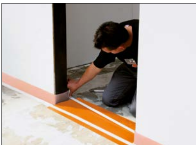
7 Türbereich – beigefügte Doppelklebebänder aufbringen.
