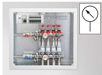
**12.** Druckprobe – Vor dem Einbringen des Estrichs ist eine Druckprüfung durchzuführen (siehe Druckprobenprotokoll, technisches Handbuch).
