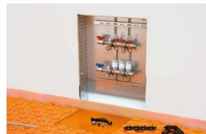
**8.** Verteilerbereich – Estrichnuppenplatten EN 23 FI 30 an die Ausgleichsplatte ENFGI 30 verlegen (Bei Fließstrichen die Stöße dicht verkleben).
