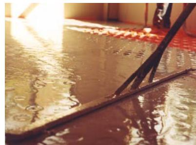
**15.** Alternativ zu **13.** und **14.**: Einbringen eines Fließestrichs: Sorgfältige Verlegung der Noppenplatten und Verschluss der Schnittkanten/Endpunkte. Ein Hinterlaufen der BEKOTEC-Platten ist zu verhindern.
