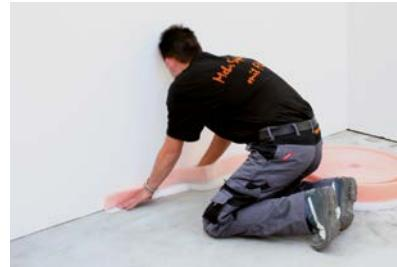
**2.** Einbau des geeigneten Randstreifens Schlüter-BEKOTEC-BRS (je nach Estrich-Art bzw. Estrichhöhe).
