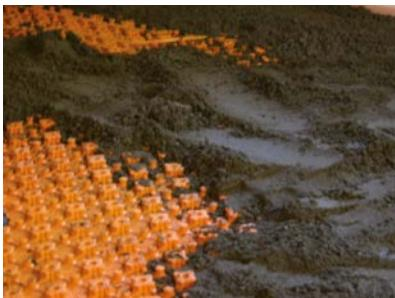
**13.** Der Einbau des Estrichmörtels erfolgt ohne Bewehrung und Bewegungsfugen (Estrichgüte CT/CA C20-C35 / F4 max. F5). Ausnahme: im Turbereich, mit Kellenschnitt oder Dehnfugenprofil Schlüter-DILEX-DFP sowie Bauwerkstrennfugen.
