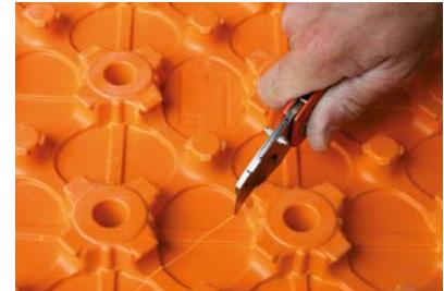
**5b.** Verarbeiten der Estrichnuppenplatte – Schneiden zwischen den Noppen: mit scharfem Messer/ Cutter anschneiden ... und brechen.
