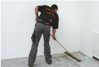
**1.** Reinigen des ausreichend tragfähigen und ebenflächigen Untergrundes.
