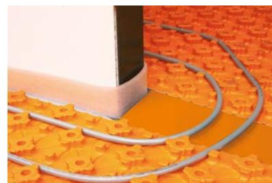
**9.** Verteilerbereich – Rohrklemmleisten Schlüter-BEKOTEC-BTZRKL zur Rohrführung nach Bedarf aufkleben.
