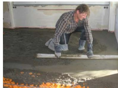
**14.** Abziehen der Estrichfläche mit einer Mindestüberdeckung von 8 mm. Höhenausgleich bei bereichsweisen Unebenheiten max. 25 mm Estrichüberdeckung (für nichtkeramische Beläge Datenblatt 9.8 beachten).
