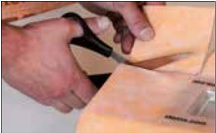
I KERDI Manschette für den Eckbereich zuschneiden.
