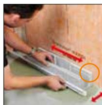
Fig. 1. Alineación del elemento portador para canaleta
