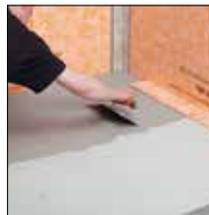
Fig. 6. Aplicación del cemento cola en capa fina
