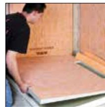
Fig. 3. Inserción del panel de pendiente debajo del borde de la canaleta
