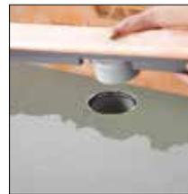
Fig. 4. Colocación de la canaleta incl. el elemento portador
