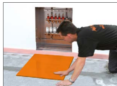
3. Fordelerområde – anbring udligningsplade EN FGTS (glat folieplade).
