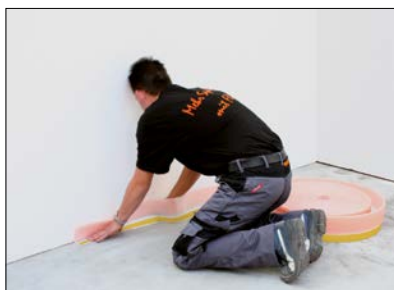
2. Montering af BRS 808 KSF-kantbånd med selvklæbende støttefod.
