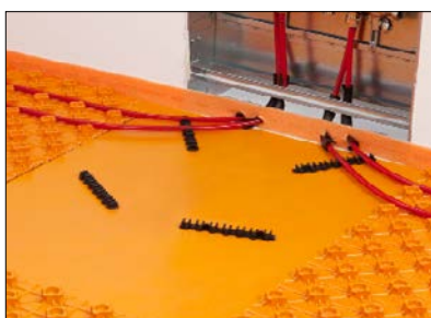
11. Fordelerområde – lim rørklemmerne BTZRKL 10/12 på til rørføring efter behov.
