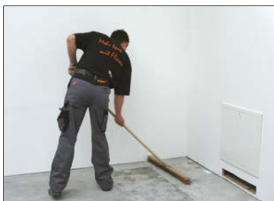
1. Rengøring af det tilstrækkeligt bærende og jævne underlag.
