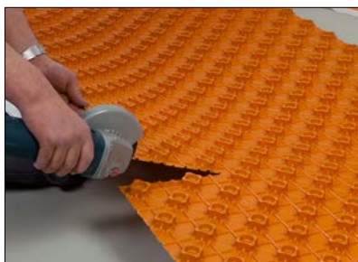
7. Bearbejdning af knoppladen - tilskæring med vinkelsliberen. I den forbindelse skal du fjerne nopperne på BEKOTECEN 18 FTS-startpladerne (se punkt 4) i kantområdet for at undgå akustiske broer.
