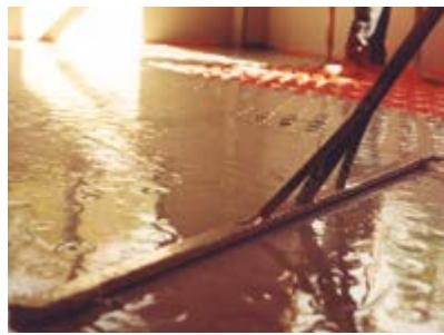
**13.** Der Einbau des Estrichmörtels erfolgt ohne Bewehrung und Bewegungsfugen (Estrichgüte CA/CT-C25-F4, max. F5). Ausnahme: im Türbereich, mit Kellenschnitt oder Dehnfugenprofil Schlüter-DILEX-DFP sowie Bauwerkstrennfugen.
