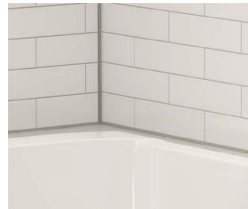
Perfil JOLLY y piezas angulares a juego se utilizan para dar el acabado a los cantos de las baldosas de las paredes y el contorno de la bañera. DILEX-EKE elimina la necesidad de sellador y crea transiciones suaves entre la pared y la encimera, la bañera y el piso.
