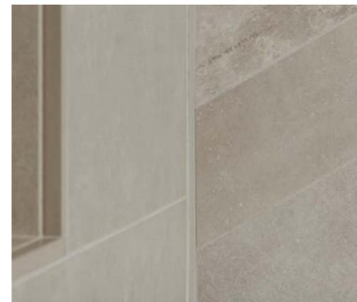
El perfil **QUADEC** de color Crema acentúa ligeramente el nicho, mientras que el **DILEX-EKE** se mezcla con la lechada y el **DECO-SG** es apenas visible dando apoyo al panel de vidrio de la ducha.
