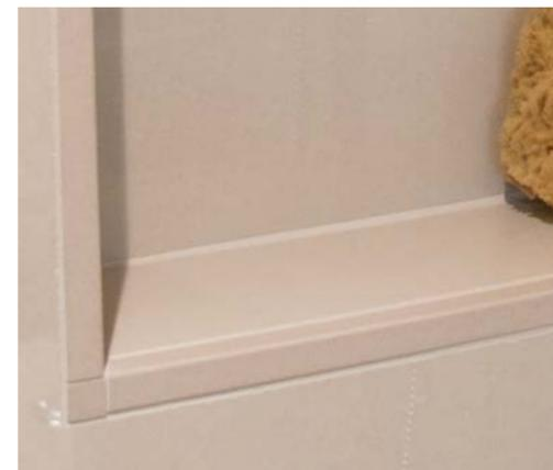
Perfiles y ángulos cuadrados **QUADEC**, se usan para dar el acabado a los cantos de las baldosas en la pared, al reborde de ducha y al nicho. Perfil angular de movimiento **DILEX-EKE** PVC fue usado para crear una transición uniforme entre el piso y las paredes de la ducha.
