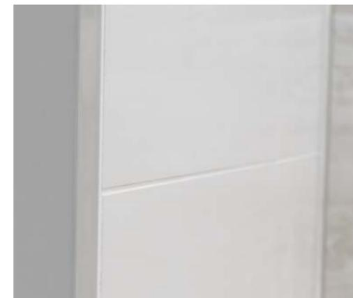
Ángulos y perfiles cuadrados **QUADEC** usados para dar el acabado a los cantos de las baldosas del reborde de ducha, del banco y del nicho. El perfil **JOLLY** protege los cantos de la pared de la ducha, mientras que el perfil **DILEX-EKE** elimina la necesidad de usar selladores en la ducha y crea una transición suave entre las paredes y el piso. El perfil **DESIGNBASE-SL** y sus accesorios a juego en color blanco mate garantizan una apariencia uniforme y elegante en toda la base de la pared.
