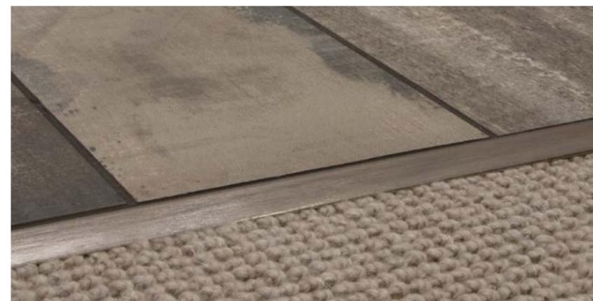
Perfil de piso **RENO-TK** usado para crear una transición suave entre la baldosa y la alfombra. Perfil redondeado **RONDEC** combinado con sus ángulos usados para dar el acabado a los cantos de las baldosas en el zoclo. Perfil de junta angular de movimiento **DILEX-EKE** PVC usado para crear una transición uniforme entre el piso y la pared.
