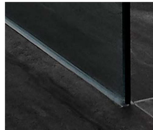
**JOLLY** ofrece una apariencia discreta y minimalista para enmarcar de manera elegante el alargado nicho. **DILEX-EKE** elimina la necesidad de usar selladores y crea una mejor transición entre el piso y la pared. **DECO-SG** funciona como canal de soporte para el panel de vidrio.
