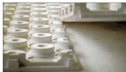
Plaatsen en samenvoegen van dekvloernoppenplaten Schlüter-BEKOTEC-EN P (-EN PF)
