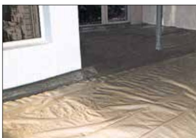
Inbouw van de scheidingslaag
