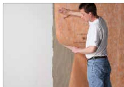
Schlüter-DITRA ist eine Polyethylenbahn mit schwalbenschwanzförmig hinterschnittenen, quadratischen Vertiefungen, die rückseitig mit einem Trägervlies versehen ist. DITRA dient in Verbindung mit Fliesenbelägen als Abdichtung, Dampfdruckausgleichsschicht bei rückwärtiger Feuchtigkeit und Entkopplungsschicht.
