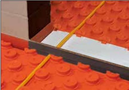
Herkömmliche Estriche sind unabhängig vom Bodenbelag mit Bewegungsfugen in entsprechende Feldgrößen zu unterteilen. Diese aufwändige Aufteilung der Estrichfelder und die damit verbundene Abstimmung mit den einzelnen Gewerken entfällt systembedingt beim Einsatz des Schlüter-BEKOTEC-Systems.
