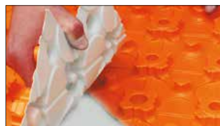
Auslegen und Zusammenfügen der Estrich-Noppenplatte Schlüter-BEKOTEC-EN 23 F
