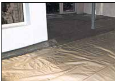
Einbau der Trennlage
