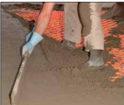
Vor Einbringen des Estrichs ist das Heizsystem durch eine Druckprobe auf Dichtheit zu überprüfen. Es ist sicherzustellen, dass keine Beheizung des Systems während der Einbringung und des Abbindeprozesses des Estrichs erfolgt.
