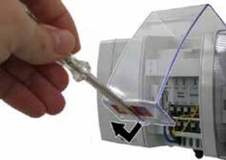
1. Abra la cubierta usando un destornillador plano.
