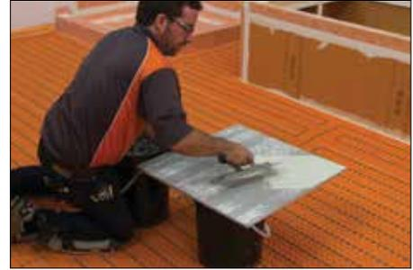
**3** Soulevez de temps en temps des carreaux pour vérifier la couverture.
