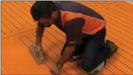
**5** Veillez à ne pas endommager les câbles durant la pose, particulièrement avant de les encastrer dans la membrane.
