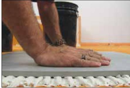
**2** Encastrez les carreaux dans le ciment-colle, en effectuant un mouvement de va-et-vient perpendiculaire aux crêtes de ciment-colle. Vous écraserez ainsi les crêtes et améliorerez l'adhésion des carreaux. Assurez-vous de respecter le temps d'ouverture du produit. Si le ciment-colle forme une peau avant que les carreaux y soient déposés, retirez-le et appliquez-en une nouvelle couche.
