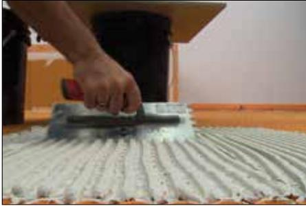
**1** Les carreaux peuvent être posés immédiatement sur les membranes DITRA-HEAT/-PS et DITRA-HEAT-DUO/-PS; nul besoin d'attendre que le ciment-colle durcisse. Remplissez les espaces de la membrane avec Schluter SET, ALL-SET, FAST-SET ou du ciment-colle non modifié, et étendez une autre couche de ciment-colle sur la membrane en utilisant une truelle adaptée au format des carreaux.
