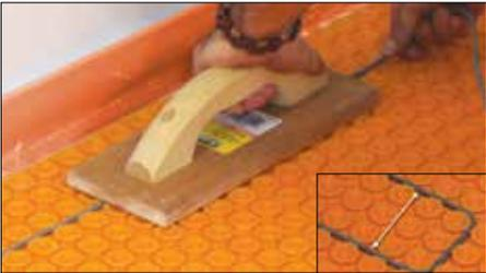
**4** Insérez les câbles chauffants entre les crampons selon la disposition recommandée, selon l'espacement déterminé à la section **Espacement** voir les pages 20-21.
