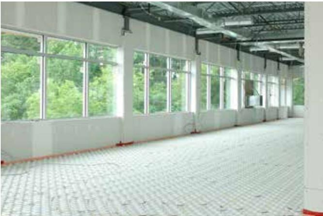
puede regularse adecuadamente en un rango de bajas temperaturas. Como las tuberías están colocadas cerca de la superficie del piso, el tiempo de reacción es ocho veces menor que el de un sistema hidráulico tradicional. Utilizamos este sistema en toda la instalación: por debajo de las baldosas en los espacios de oficinas, así como por debajo de las losas de hormigón en el almacén.
