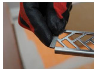
Pressez les capuchons de fermeture en acier inoxydable sur les extrémités coupées de la grille. **Remarque :** Les capuchons sont ajustés par compression et ne nécessitent pas d'adhésif pour l'installation.
