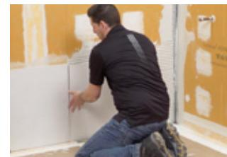
Determine la colocación de las baldosas e instale la primera hilera de baldosas en las paredes laterales y en la pared posterior.
