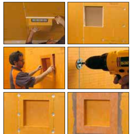
Instalación con Schlüter-KERDI-BOARD:
