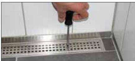
Assemblage de grille SQUARE avec mécanisme de verrouillage
