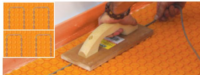
**2** Encastrez les câbles chauffants entre les crampons à 3 crampons d'intervalle ou en alternance à 3, puis 2 crampons, selon l'application. Pour en savoir plus, veuillez consulter le manuel d'installation DITRA-HEAT, que vous trouverez dans la section consacrée aux planchers chauffants du site schluter.ca.
