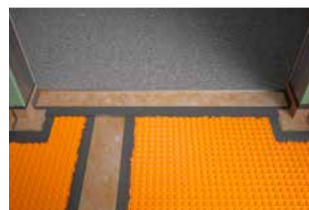
Schlüter-KERDI-CID con pavimento en pendiente (pendiente máx. 6 %)
