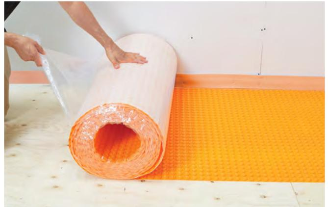
Para instalar, basta con retirar la película protectora y adherir la membrana DITRA-HEAT-PS o DITRA-HEAT-DUO-PS.
