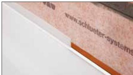
**7 a** Optional kann der Schneidschutz Schlüter-KERDI-CP im frisch eingebrachten Montagekleber Schlüter-KERDI-FIX eingebettet werden. Er dient als Schutz der Anschlussdichtung während einer späteren Erneuerung der Silikonfuge. Hierzu ist das entsprechend abzulängende Kunststoffprofil vorzuknicken und ggf. zusätzlich an der anliegenden Wand mit KERDI-FIX zu fixieren.
