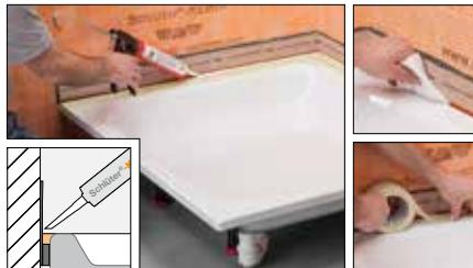
**6** Fugenbereich mit dem zweiten Reingungstuch säubern und Randoberfläche des Einbauteils mit einem Malerband abdecken. Die Fuge mit Montagekleber Schlüter-KERDI-FIX bis Oberkante Wannenrand verfüllen. Anschließend Malerband wieder entfernen. Frische KERDI-FIX Kleberreste können mit Sprühöl (z. B. WD-40) entfernt werden. Fläche anschließend gründlich entfetten.
