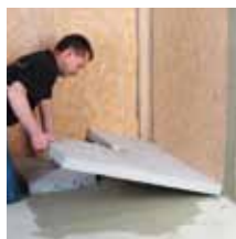
ad 1. og 2. Udligningselementet lægges ud.
