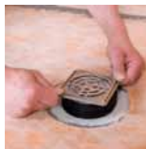
ad 9. Den rustfrit stålrist med højdefiksering og vandlås i sættes til den ønskede højde, med hensyn til den senere belægning.
