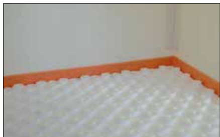
Installationseksempel på kantbånd BRS 810 eller BRSK 810 med foliefod
