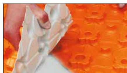
Udlægning og samling af den noprede Schlüter-BEKOTEC-EN 23 F plade til gulvmasse
