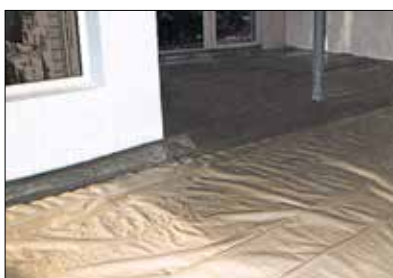
Montering af separationslag
