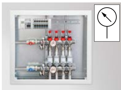
14. Trykprøvning – Før afretningslaget lægges, skal der udføres en trykprøvning (se trykprøvningsprotokol i den tekniske manual).
