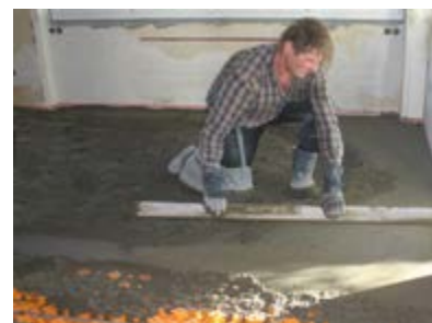
16. Udjævning af afretningsfladen med et overlap på mindst 8 mm højdekompensation for ujævnheder i områder op til maks. 25 mm afretningsoverlap (for ikke-keramiske belægninger, se datablad 9.2).
