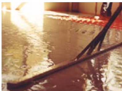
17. alternativt til 15 og 16 : Lægning af et flydende afretningslag på en nopret gulvmonteringsplade EN 23 F. For at opnå en jævn overflade, er det hensigtsmæssigt at svuppe med en grov kost eller en svupper (afretningslagskvalitet CAF/CTF-C25-F4, maks. F5).
