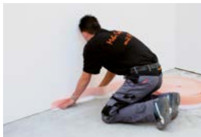
2. Montering af den egnede kantliste Schlüter-BEKOtec-BRS (alt efter gulvmassens type og højde).
