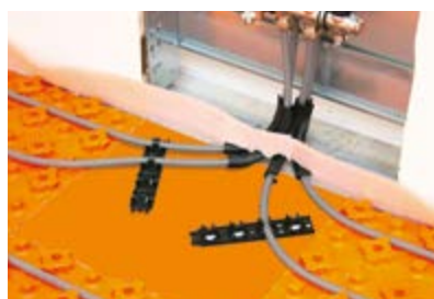
9. Fordelerområde – lim rørklemmer Schlüter-BEKOtec-BTZRKL til rørføring på efter behov.
