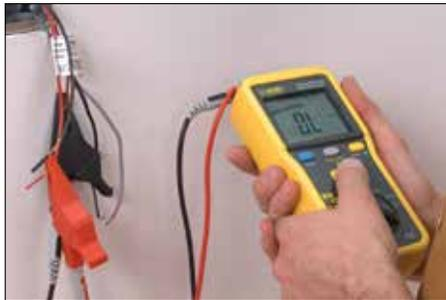
4 Una vez terminada la instalación de las baldosas, comprobar otra vez el cable de calefacción y anotar los resultados en el registro de pruebas al cable de calefacción (página 39).
