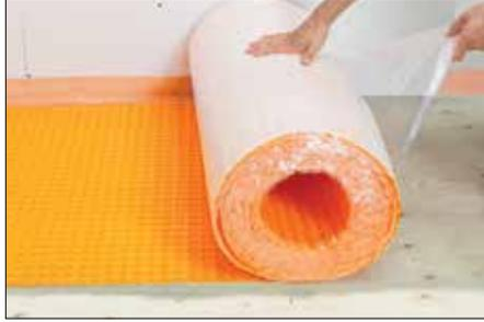
**2** Coloque la membrana autoadhesiva sobre el piso, con el geotextil/adhesivo hacia abajo. Presione firmemente la membrana en el sustrato utilizando una flota, una llana o el rodillo DITRA-ROLLER. Una instalación correcta da como resultado un contacto total entre el adhesivo y el sustrato que se encuentra debajo.
