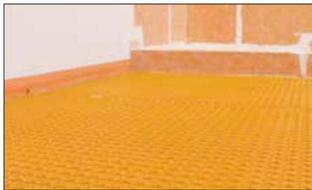
4 Alinear los bordes y secciones laterales de las láminas adyacentes. **Nota:** Alinear los nódulos en la parte superior de la membrana durante la instalación puede contribuir a hacer más fácil la posterior instalación de los cables de calefacción.
