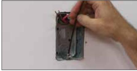
**2** Haga pasar el conductor frío del cable de calefacción a través de un conducto desde la base de la pared hasta la caja eléctrica del termostato. Los sensores de temperatura del piso deben pasar por el mismo conducto del conductor frío o por otro conducto.
