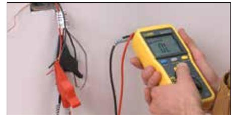
**7** Una vez terminada la instalación del cable de calefacción y del sensor de temperatura del piso, realizar las pruebas nuevamente y anotar los resultados en el registro de pruebas al cable de calefacción (página 39).
