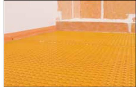
**3** Instale las láminas adyacentes y alinee los nódulos en la parte superior de la membrana para facilitar la colocación del cable de calefacción.
