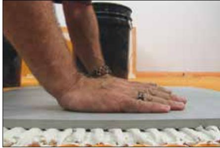
2 Adhiera firmemente las baldosas en el material de instalación deslizando la baldosa hacia adelante y hacia atrás en dirección perpendicular a las dentadas de mortero. Esto permitirá que las dentadas de mortero colapsen y mejorará el contacto entre el mortero y las baldosas. Asegúrese de observar el tiempo abierto del mortero adhesivo. Si se forma una película en la superficie del mortero antes de la instalación de la baldosa, retirarlo y volver a aplicarlo.
