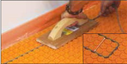
**4** Fije el cable de calefacción entre los nódulos utilizando el patrón recomendado a un espaciado determinado en la sección de **Detalles de espaciado** en las páginas 20-21.
