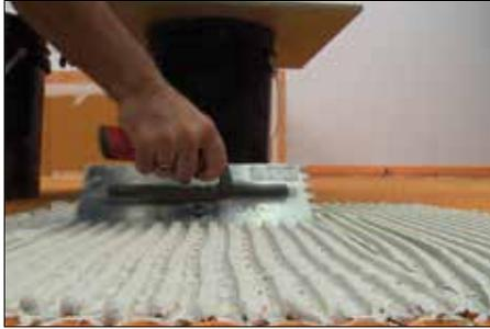
1 La baldosa se puede instalar inmediatamente sobre DITRA-HEAT/-PS y DITRA-HEAT-DUO/-PS; no es necesario esperar a que el mortero fragüe. Rellenar la membrana con Schluter SET, ALL-SET, FAST-SET, o mortero adhesivo no modificado y aplicar más mortero sobre la membrana con una llana que sea apropiada para el tamaño de la baldosa.
