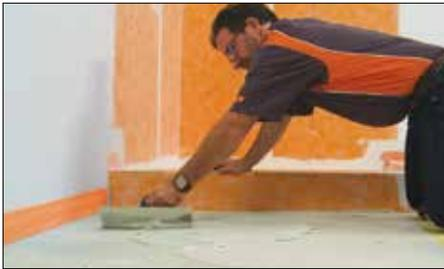
1 Usando un mortero adhesivo apropiado para el sustrato, aplicar el mortero adhesivo (mezclado a una consistencia bastante líquida, pero capaz de seguir manteniendo la dentada) usando la llana DITRA-HEAT o alguna otra llana de dientes cuadrados de 1/4" x 1/4" (6 mm x 6 mm). Aplique una capa fina de mortero con el lado plano de la llana y extienda otra capa con el lado dentado.
