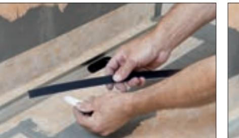
4 Beim Wandeinbau: Schutzfolie des Abdeckstreifens abziehen und ...
