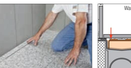
11 Belag aufkleben und ausrichten. Beim Verfügen ist der Bereich des Belagträgers auszusparen.
