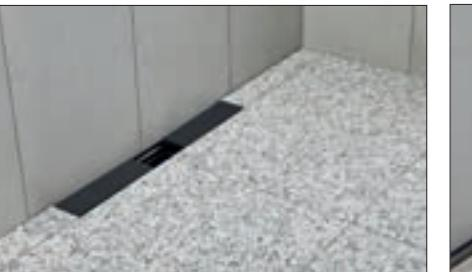
7 ... den Belag anarbeiten. Herausquellenden Dünnbettmörtel rückstandslos entfernen bzw. offene Bereiche in der Kleberschicht vollständig verschließen, siehe Hinweis.
