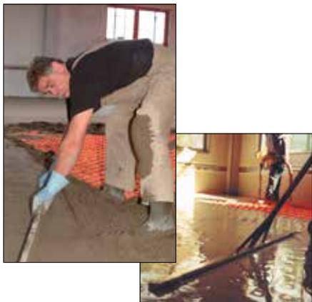
Prima della posa del massetto si deve effettuare una prova di tenuta sotto pressione del tubo, assicurandosi che il sistema rimanga spento durante la fase di installazione e di maturazione del massetto.
