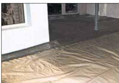
Esempio di installazione di un telo di separazione
