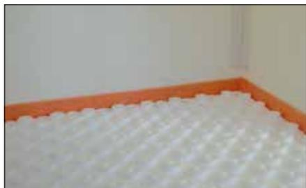
Esempio di posa della fascetta BRS 810 oppure BRSK 810 con bandella autoadesiva
