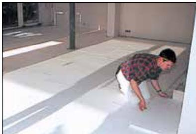
Posa dell'isolamento termico e acustico su un solaio portante con sufficienti caratteristiche di portata e planarità
