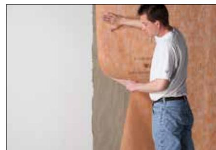
Schlüter-KERDI è una guaina impermeabilizzante in polietilene, dotata di un tessuto su entrambi i lati che ne facilita l'ancoraggio al collante. E' particolarmente adatta per l'impermeabilizzazione in abbinamento con i rivestimenti ceramici.
