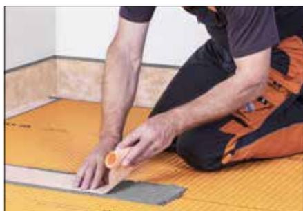
Schlüter-DITRA è una guaina in polietilene con quadratini cavi sagomati a coda di rondine, rivestita sul retro con un tessuto. Da rivestire con piastrelle, DITRA funge da strato desolidarizzante - impermeabilizzante e di sfogo della pressione del vapore.
