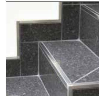
Arestas de escadas e remates da base
