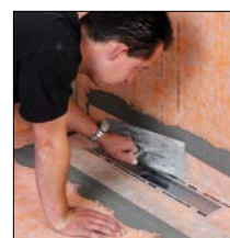
bij 4. KERDI-manchet met KERDI-COLL-L verlijmen
