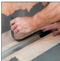
bij 1. Bij wandinbouw: lijm de afdekstrook tegen de wand vast
