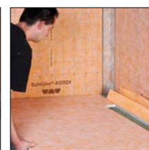
bij 3. Hellingsplaat onder de rand van de goot schuiven
