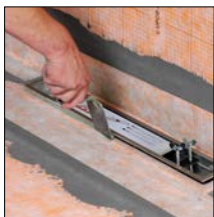
bij 3. Breng dunbedmortel onder het frame/betegel het oppervlak
