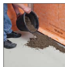
bij 3. Nivelleringslaag aanbrengen
