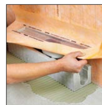
bij 2. Goot plaatsen
