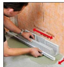
bij 1. Lijn de gootdrager uit
