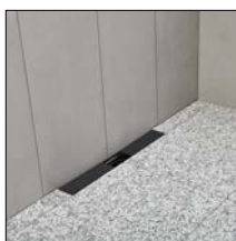
bij 3. Breng de bekleding op het doucheoppervlak aan
