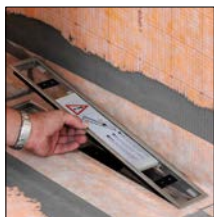
bij 1. Plaats het frame incl. afstandhouder
