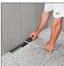
bij 4. Bepaal de afmeting van de bekleding voor de tegeldrager ...
